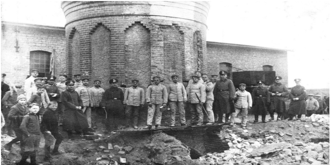
Vorbereitung der Sprengung eines Schornsteines 1937\ Privatfoto\ Ausschnitt H. Bartzack\
